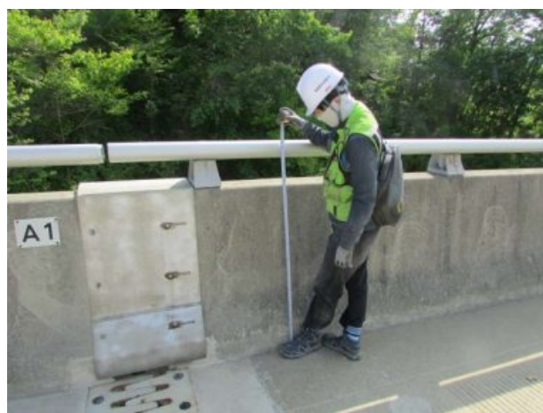
방호벽 부재제원 확인 전경
