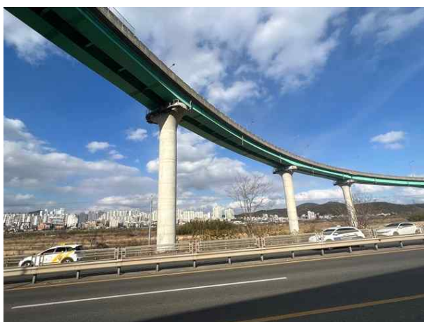
하부 (P3~P5) 전경
