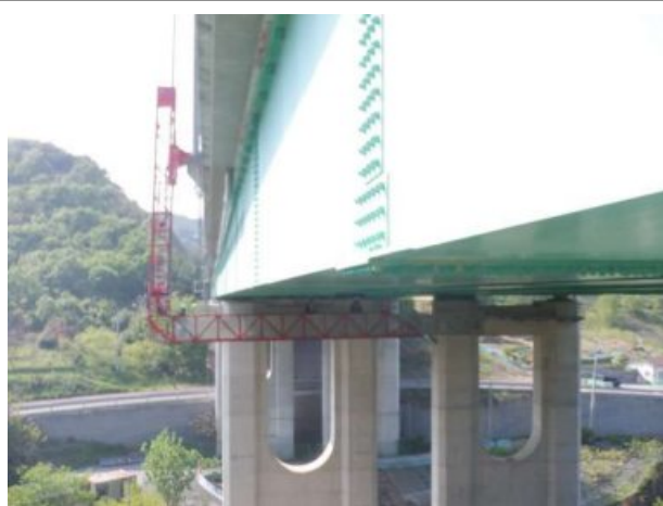
교량점검차를 이용한 현장조사
