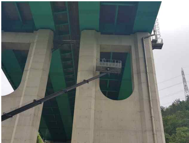
내용 : 교각 코핑부 상태 양호
