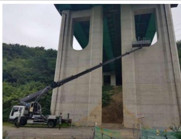
고소작업차를 이용한 현장조사
