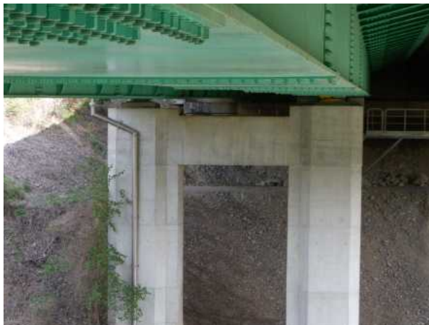
내용 : 교각 코핑부 상태 양호
